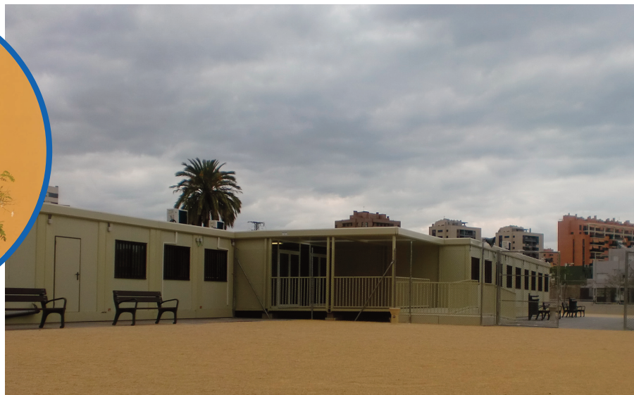
A la izquierda, antiguo Manjón Cervantes y detalle de las grietas. Arriba, actuales aulas prefabricadas en las que se ha establecido el colegio. A la derecha, manifestación 24 de febrero de la AMPA. Abajo, un pasillo del colegio que ha sido cubierto para evitar los constipados de los niños. / Amor Alonso, Imagen AMPA
